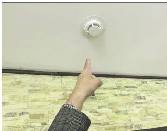
крепят на потолке с помощью двух шурупов или, если в доме натяжные потолки, в верхней части стены.
